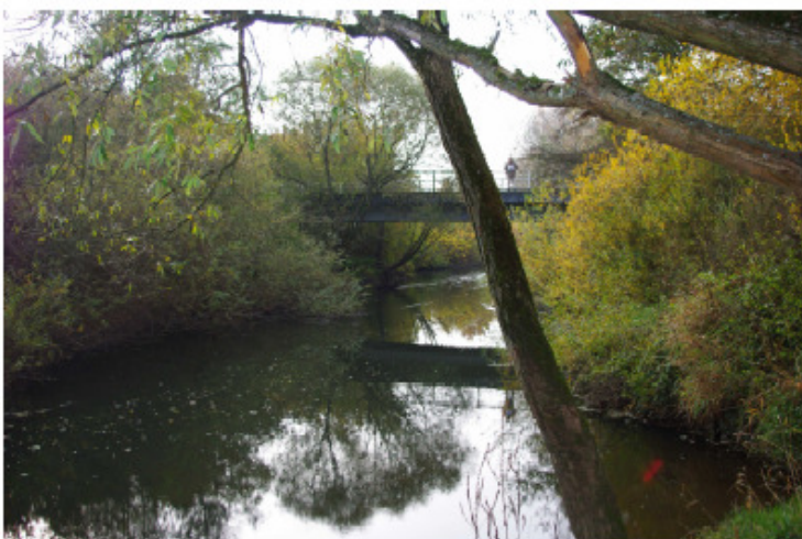
Unterhalb einer Brücke kann ein Steg für Amphibien und andere Kleintiere als Querungshilfe angebracht werden.
