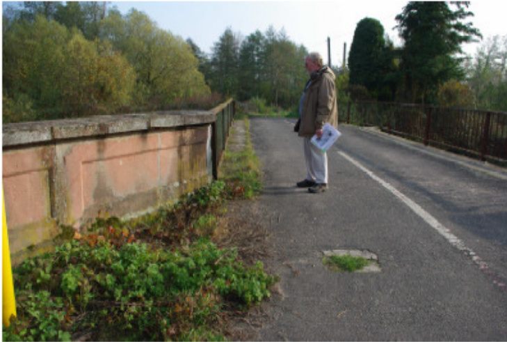
Brücke über die Kinzig. Die Straße mündet am Ende der Brücke in einen Fußweg.
