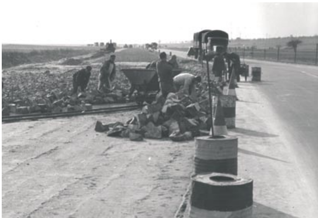
Bau der B 26.
