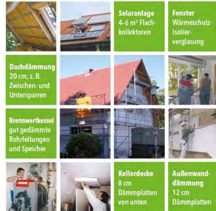
Dämmdickenangaben beziehen sich auf eine Wärmeleitfähigkeit von 0,04 W/(mK).
