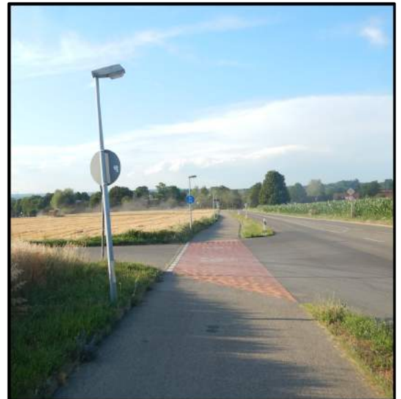
Abbildung: Straßenbegleitender Radweg im Querungsbereich in Kirchheim unter Teck
