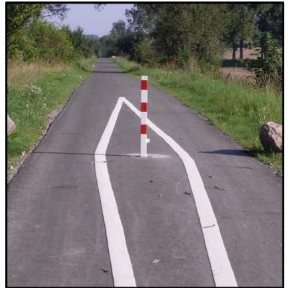
Abbildung: Warnmarkierung eines Sperrpfostens
