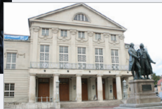
Am Bühneneingang des Deutschen Nationaltheaters in Weimar sind Innovationen von Gutjahr eingebaut.
