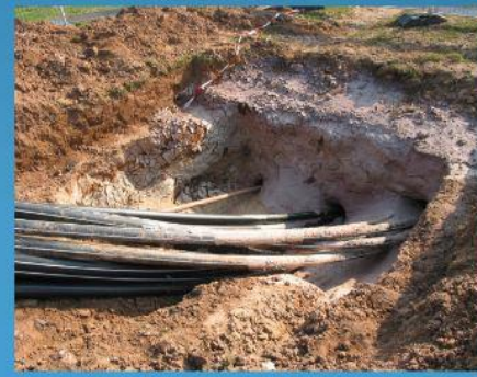
Zielgenaue 3. Pilotbohrung (links) und 2 eingezogene Rohrpakete (2 x 8 Stück Dago x 8,2 mm KSR) in einer Zielgrube 2 x 2 m
