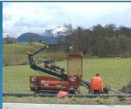
Bohranlagen in Vorbereitung zur Maindükerung . . . und Längsbohrung
