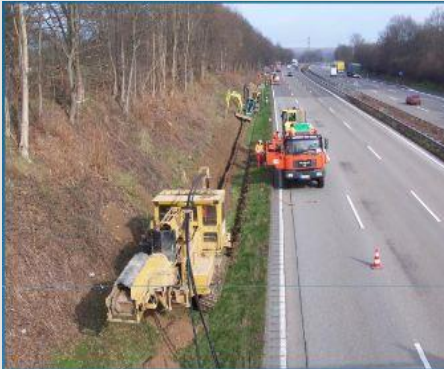
Erdfräse (Einzug von 3 KSR) mit nachlaufender Oberflächenwiederherstellung
