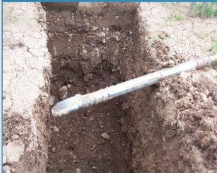
Pilotsonde im Vortrieb kurz vorm Einstich ins Erdreich
