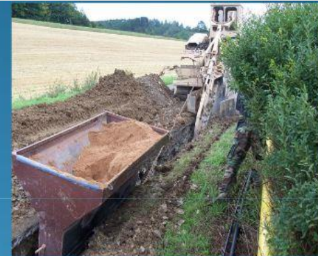
Erdfräse mit mitaufender Sandumhüllung
