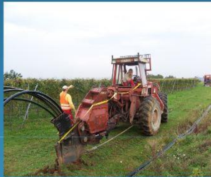
Radpflug m. Vibrationschwert (4 KSR + Trassenwarnband)
