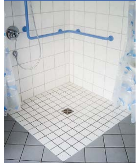
Dusche nachher: ebenerdig
