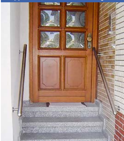
Treppe mit Handläufen beidseitig
