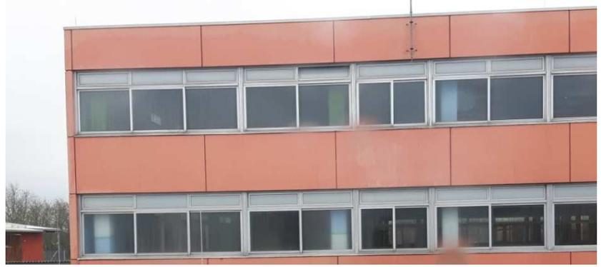
Die bestehenden ungedämmten und undichten Aluminium-Schiebefenster wurden ebenfalls im Rahmen der Abbrucharbeiten demontiert. Die neuen passivhaustauglichen Holz-Aluminium-Fenster wurden ab März 2017 in die Dämmebene gebaut. Die Dreifachverglasung hat einen U-Wert von  $0,6 \text{ W/m}^2\text{K}$ , der U-Wert des Holz-Rahmens mit aufgesetzter Aluminiumschale beträgt  $1,14 \text{ W/m}^2\text{K}$ .
