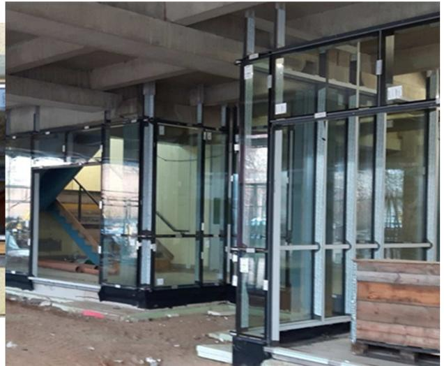
Ein Teil der Fassade wurde als Pfosten-Riegel-Konstruktion ausgeführt, auch diese Verglasung hat einen sehr guten U-Wert von  $0,6 \text{ W/m}^2\text{K}$ , so dass der U-Wert über alle Fenster im Mittel  $0,95 \text{ W/m}^2\text{K}$  beträgt.
