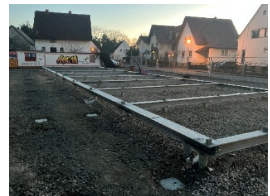
Fertige Fundamentierung
