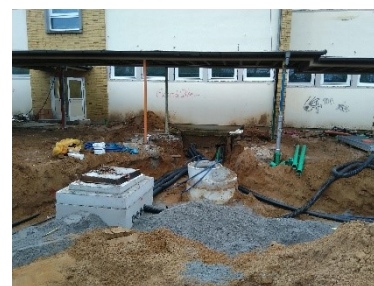
Tiefbauarbeiten vor Gebäude 002
