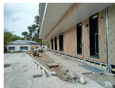
Pflasterarbeiten vor Westfassade
