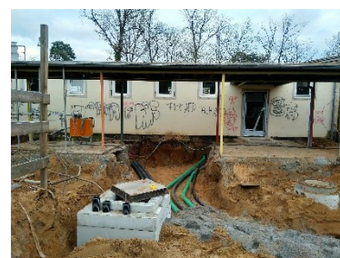
Tiefbauarbeiten vor Gebäude 006
