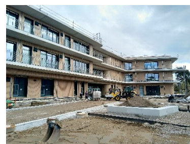
Freianlagen West / Haupteingang
