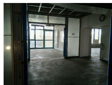
Gruppenraum Vorarbeiten Bodenbelag
