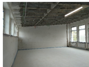
Sanierung Dämmputz und Trockenestrich
