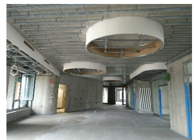
Gemeinsame Mitte Unterkonstruktion Decken
