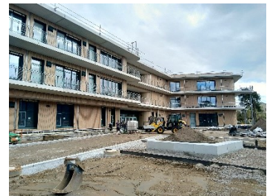
Ansicht West - Außenfassade
